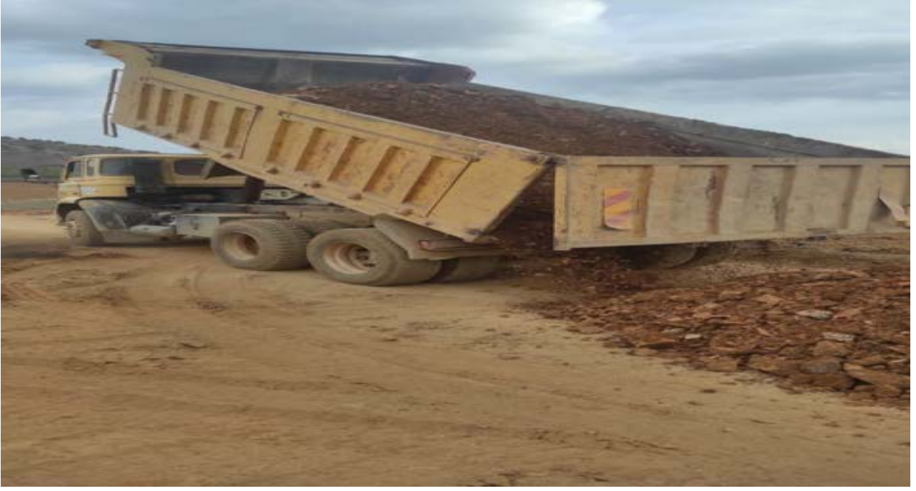
3-Ericecek Mahallesiine 3,6km Stabilize Yol Yapıldı
