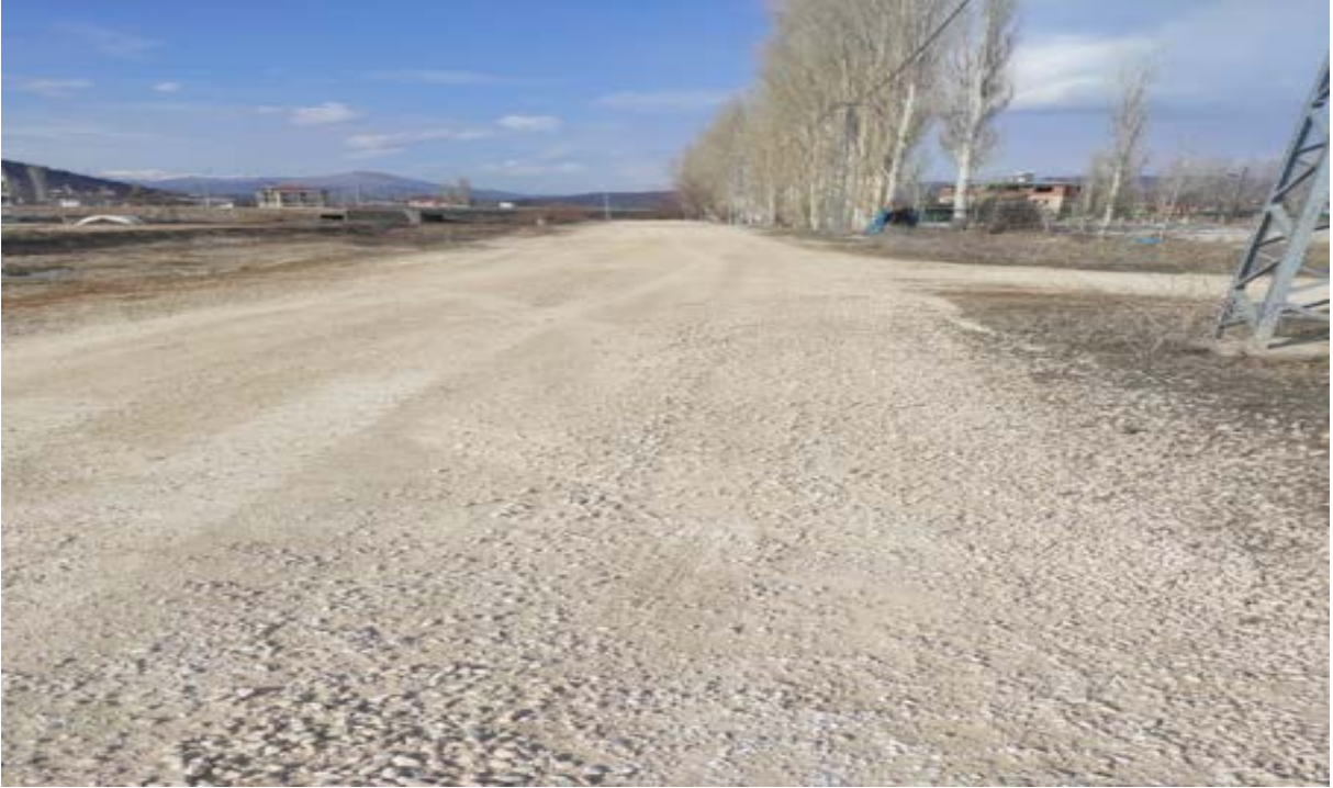
4-Çardak Mahallesiine 7,5km Stabilize Yol Yapıldı
